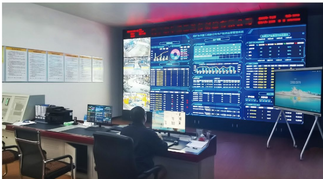
新能源锂电池智能制造车间中控系统
